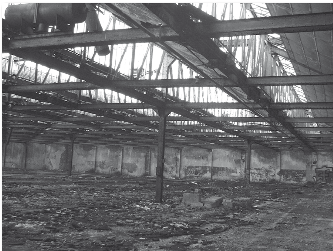
La Macérienne est une des friches industrielles les plus importantes du nord de la France. Vue de la salle qui serait sortie des ateliers d'Eiffel. © Gracia Dorel-Ferré
