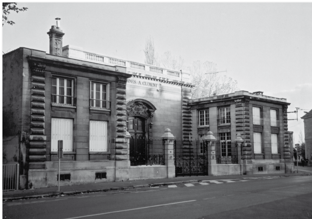
Vue des turbines A. Clément.
