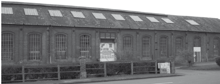
Fondée en 1875, la sucrerie Bertrand-Sarazin à Aulnois-sous-Laon a cessé son activité en 1914. Les bâtiments, caractéristiques des fabriques du XIXe siècle, sont aujourd'hui en partie restaurés et abritent les locaux de la communauté de communes du Laonnois, ainsi que quelques entreprises. © François Védrine
