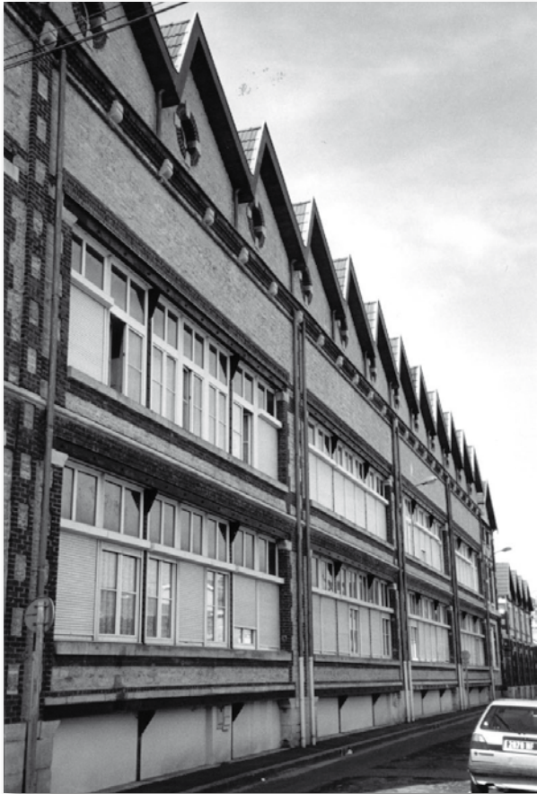
L'usine Delostal, rue Rothier transformée en logements © J-L Humbert, 2003
