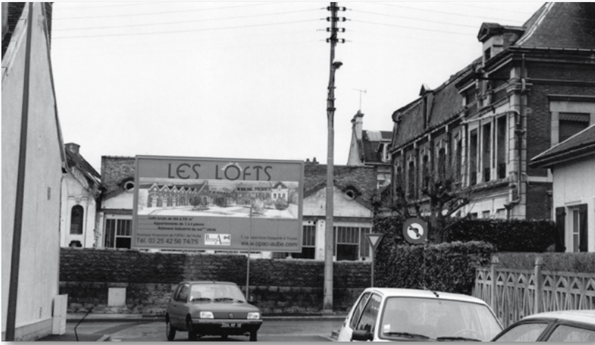
L'usine Journé-Lefèvre en cours de travaux de réhabilitation © J-L Humbert, 2003
