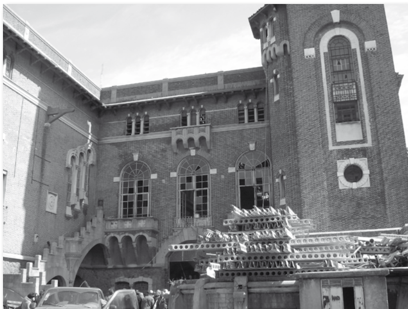
La centrale de la Compagnie italo-argentine d'électricité de Buenos Aires en cours de transformation, pour devenir le futur palais de la musique. © GDF, 2007
